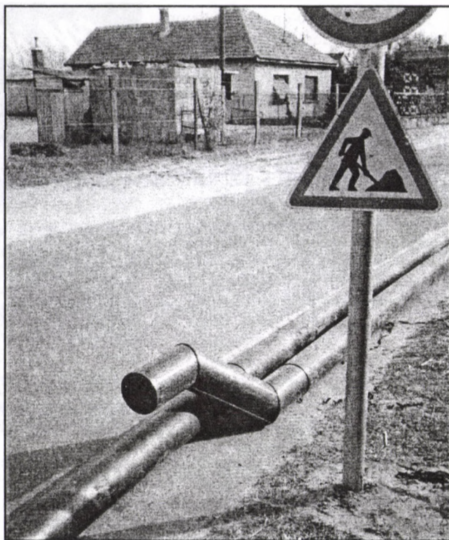
Vákuum szállítóvezeték kialakítása KPE csővezetékéből
